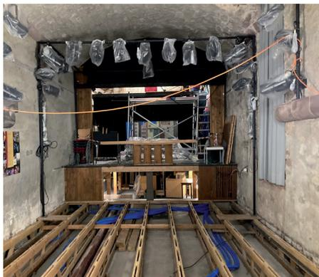
Die verbrauchte Luft wird ihrerseits an der Bühnenoberkante abgesogen und über einen Kaminschacht zu zwei Dachlukkarnen geführt. Folglich musste im Rahmen der Umbauarbeiten auch der Saalboden erneuert werden.
